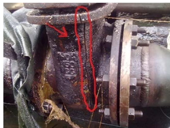
شکل ۱. ناحیه شکست Gate Valve
